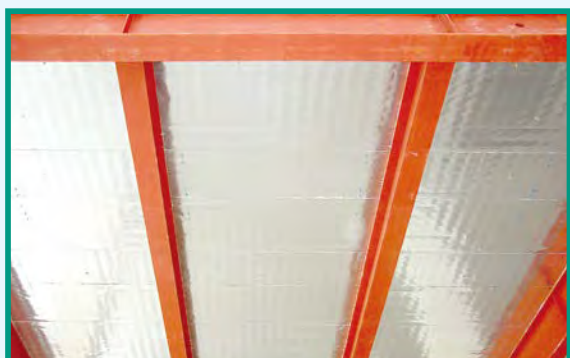
ファブデッキ裏面仕上がり
