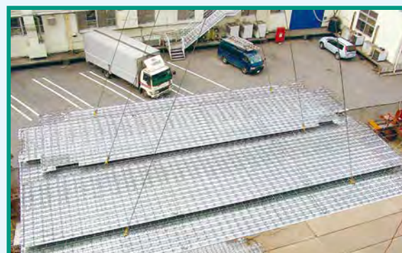
ユニット荷上げ
