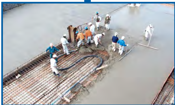
コンクリート打設
