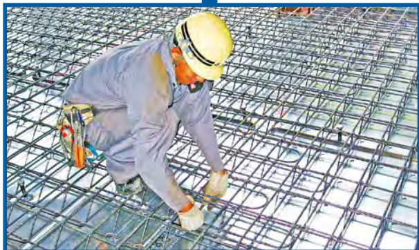
継手筋配筋
