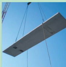
8. KHボイド板吊込
