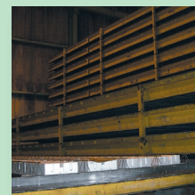
5. コンクリート養生
