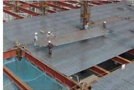
床の鉄筋と型枠を一体化させた画期的な工法であり、省力化に伴う工期短縮、工業化による高品質を実現し、様々な建物の床版に幅広く対応可能な製品です。
