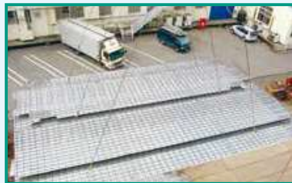
ユニット荷上げ
